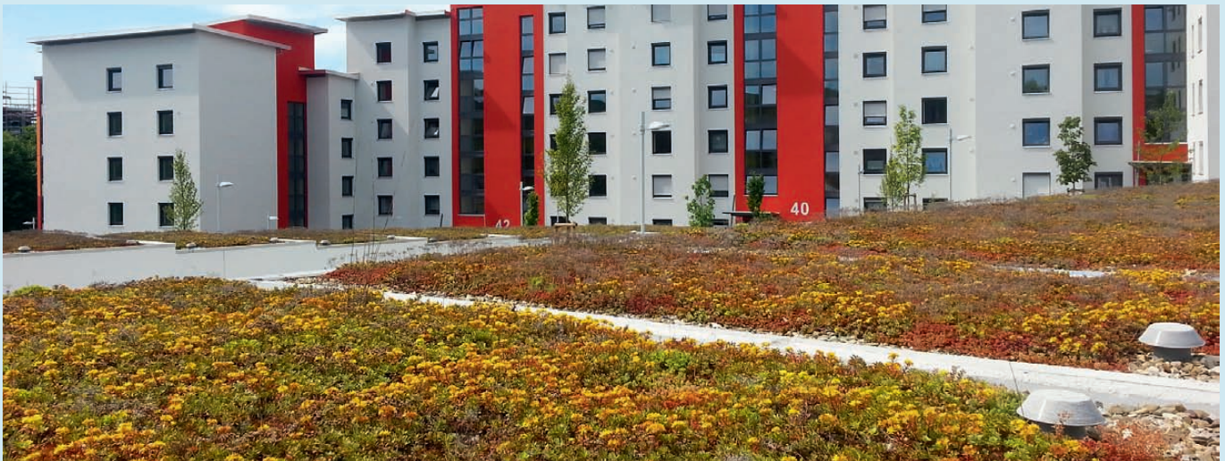
Afbeelding 11 - Ruime berging in substraat en drainagelaag met afvoerbegrenzing heeft op grote schaal ook effect op riooloverloop en kans op water op straat
