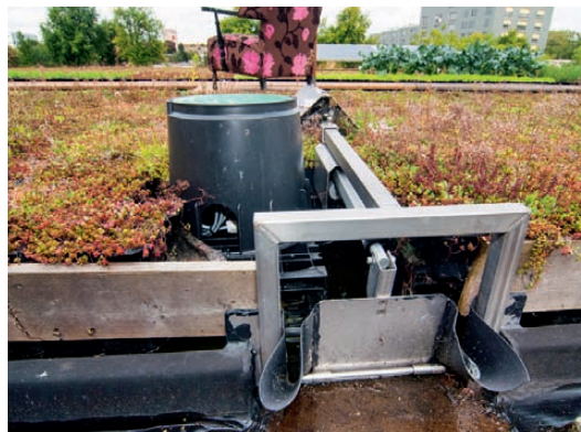
Afbeelding 7 – Elementen om afvoer bij de dakuitlaat te reguleren door afvoervertraging (links, foto BetonRestore) of door sturing met overloop (rechts, foto Polderdak © Merlijn Michon)
